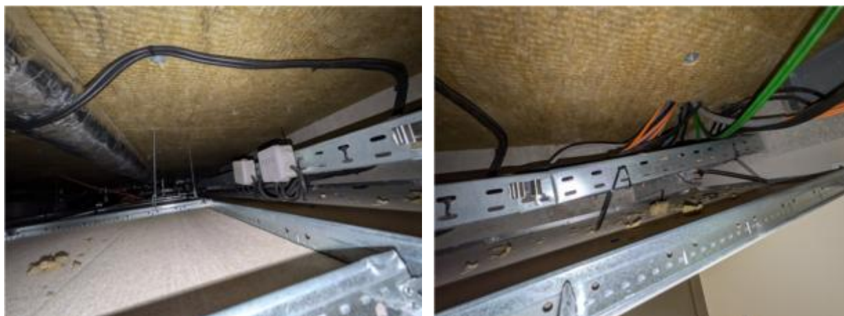
Illustration de l'isolation sous dalle existante
