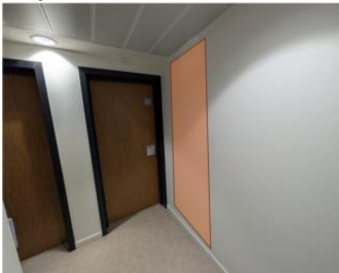
Exemple de localisation d'ouverture de gaine technique.
